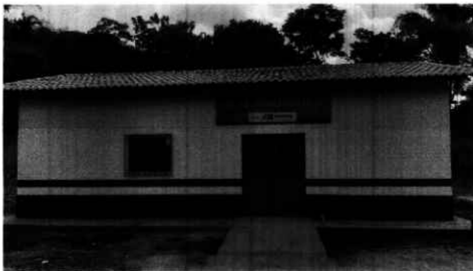
Imagem 03: construção da escola básica de uma sala e demais dependências
